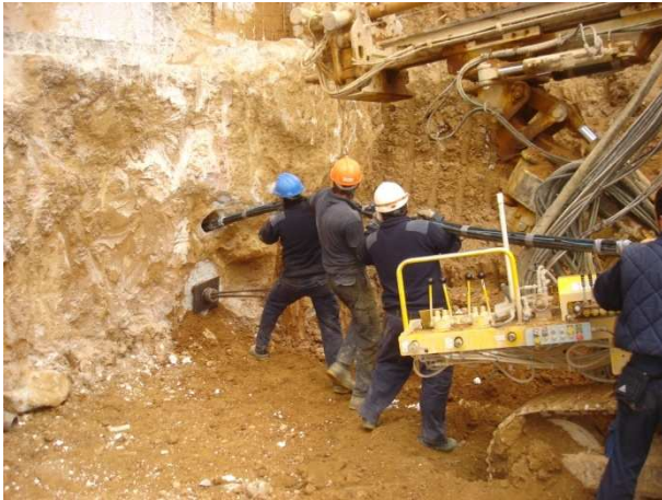
Figura 8: Introducción del anclaje
