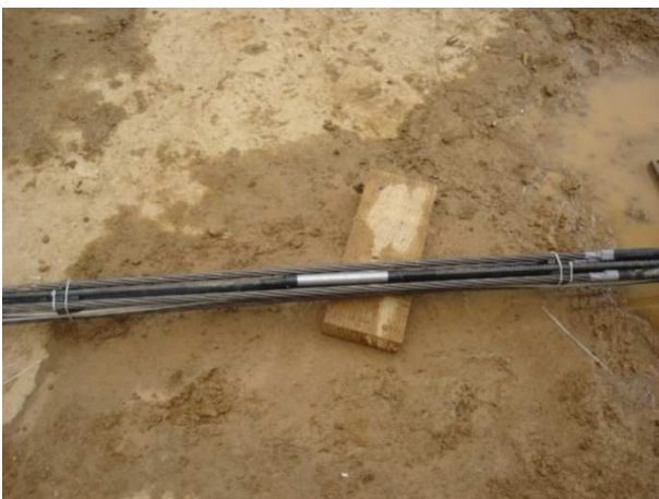
Figura 4: Sensor instalado en el bulbo de un anclaje (instalación flotante)
