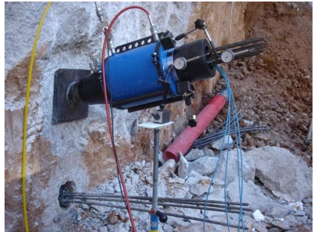
Figura 11: Colocación de gato de tesado y la instrumentación en cabeza
