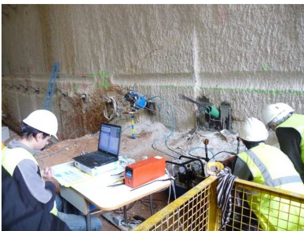
Figura 12: Montaje del sistema electrónico de control
