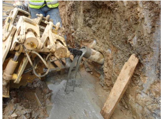
Figura 9: Inyección del anclaje
