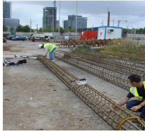
Figura 2: Colocación de los sensores de un pilote
