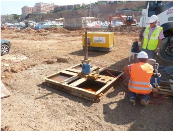
Figura 7: Ensayo a tracción de un micropilote (placa de apoyo)
