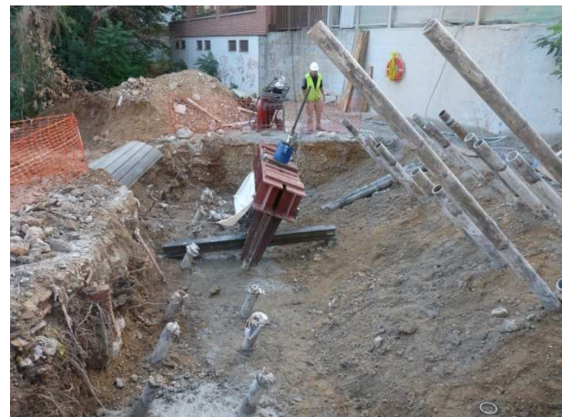
Figura 6: Ensayo a tracción de un micropilote inclinado e instrumentado (viga única)
