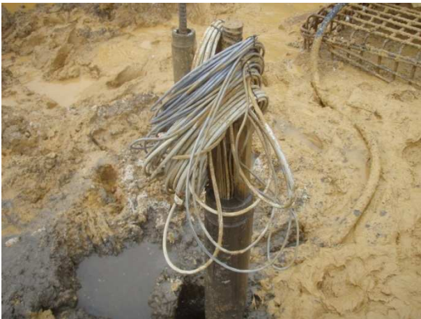
Figura 3: Cables de los sensores sobresaliendo por la cabeza del micropilote
