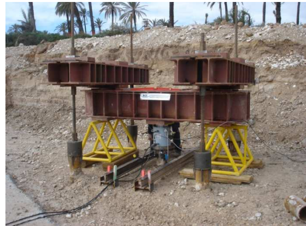
Figura 4: Ensayo a compresión micropilote instrumentado
